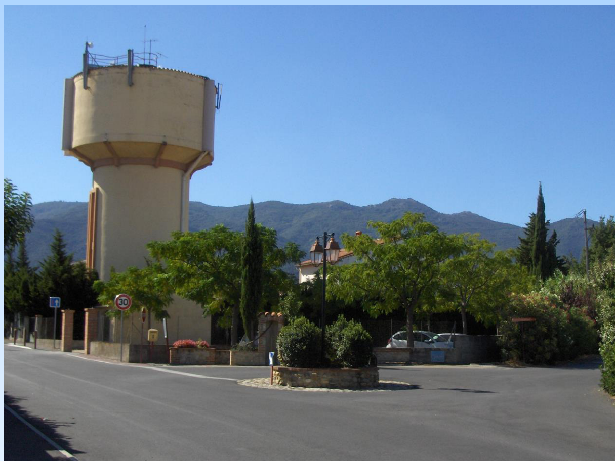
Réservoir sur tour de Saint Génis des Fontaines (2x 150 m 3 ) – Alimentation gravitaire de la commune
