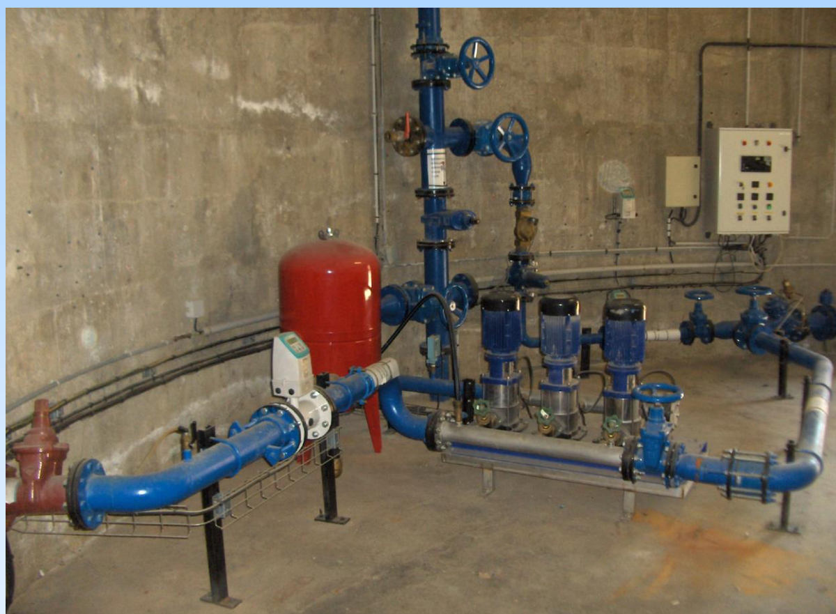
Station de surpression (3 x 20 m 3 /h) – alimentation réseau surpressé commune d'ORTAFFA
