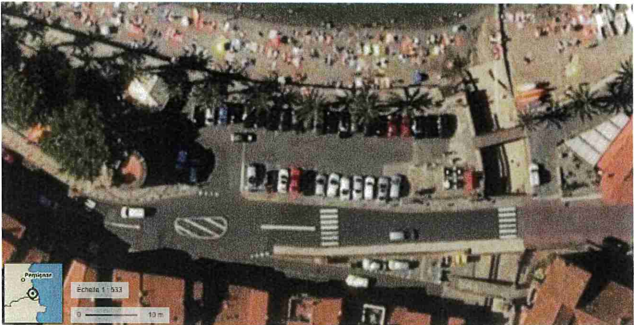
Vue aérienne du parking (Géoportail)
