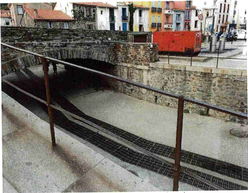
Vue de la Coma Cheric et son déversoir sur la mer
