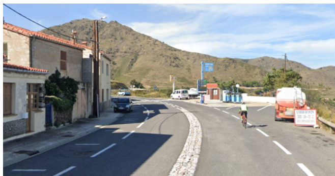
Tronçon de voie à sécuriser à la sortie du village
