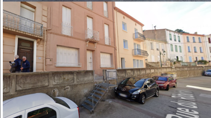
Vue des murs à conforter depuis le lit du Ribéral
