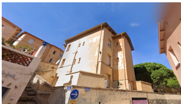
Vue de l'ancienne caserne des Douanes
