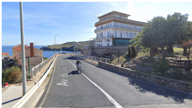
État existant de la RD914
