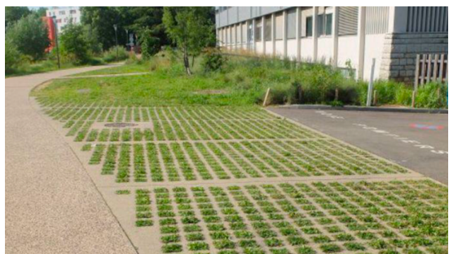
Exemple de place de stationnement perméable
