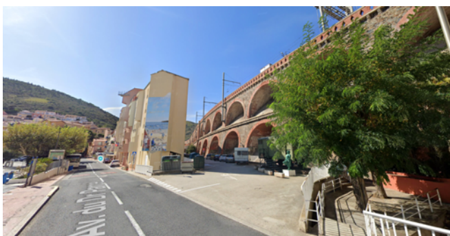
Mur de soutènement des infrastructures ferroviaires
