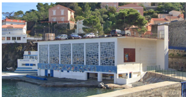
Vue du gymnase depuis la RD914
