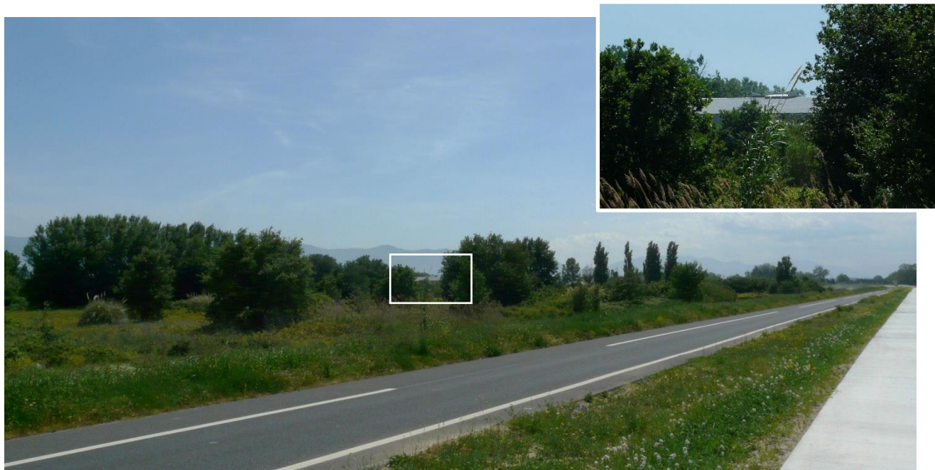
Fraction du toit de l'établissement TUBERT
