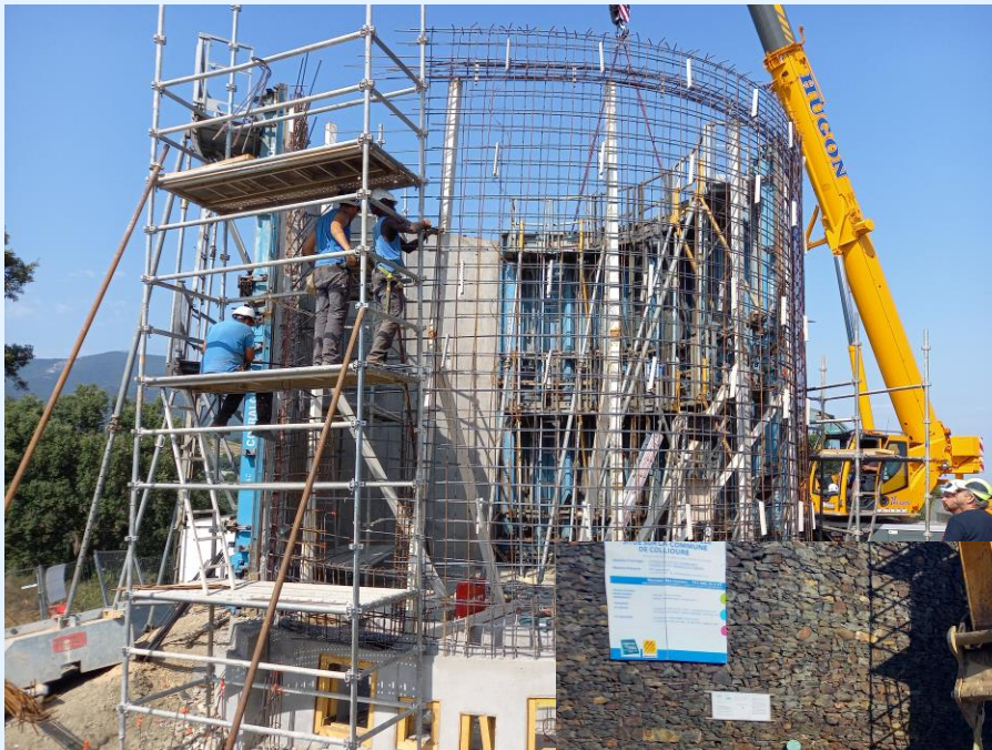
Chantier création d'un réservoir Ambeille - Collioure
