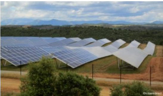
Photographie 5 : Exemple d'installation photovoltaïque au sol
