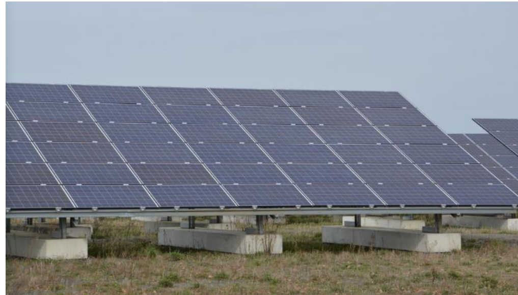
Photographie 6 : Exemple de fixation avec des plots en béton (longrines) (source : ENCIS Environnement)
