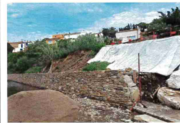
Évolution des travaux 2023
