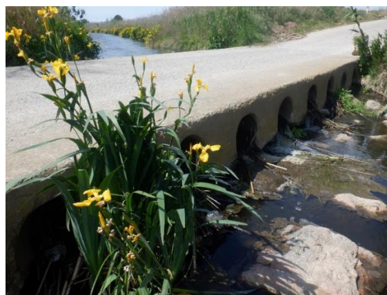
Passage à gué qui sera remplacé par un pont dans le projet
