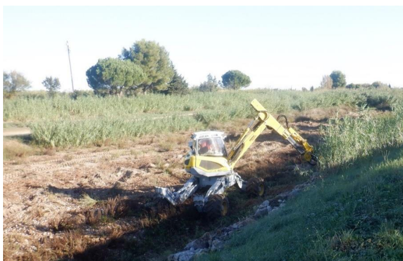
Ripage des atterrissements du Réart par l'entreprise ARF
