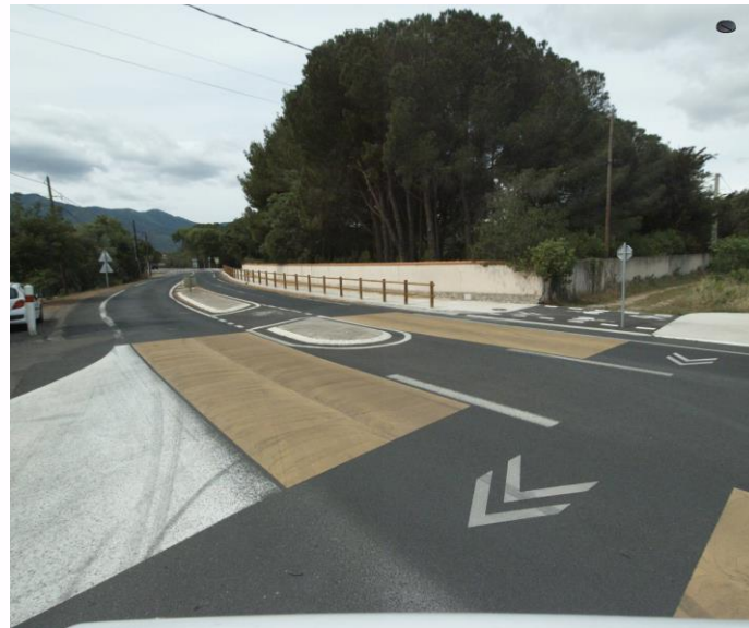
Marquage d'un carrefour à Sorède
