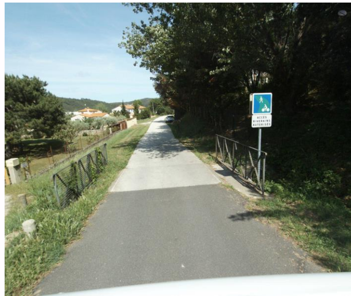
Voie verte avec accès riverains autorisé à Arles
