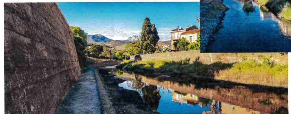
Création d'un lit emboîté fonctionnel et installation du cheminement
