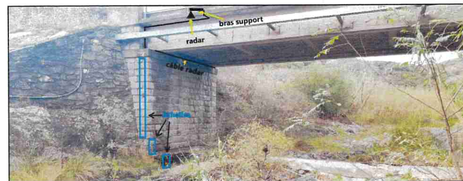
Site potentiel d'implantation d'une station de surveillance des crues sur la Massane (à côté) et sur la Baillaury (au dessus)
