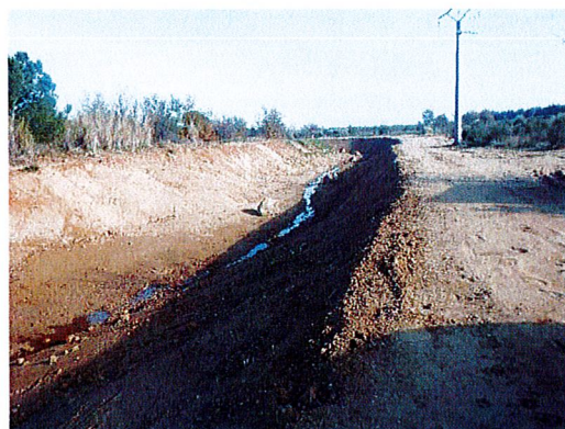
Secteur amont après travaux
