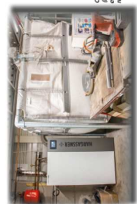
Chaudière Hargassner Nemo PK 20, silo balle et vase d'expansion (en rouge)
