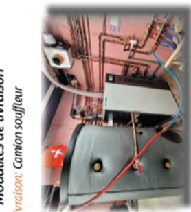
Chaudière et ballon tampon pour le chauffage et l'ECS cylindre gris
